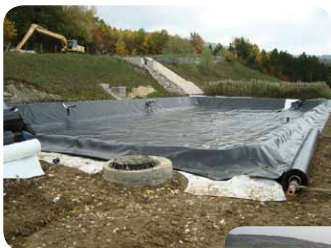
Pose de la membrane d'étanchéité
