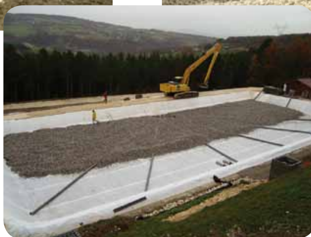
Garnissage du lit en matériaux filtrants
