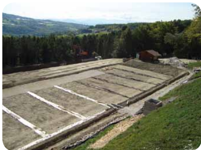
Les drains de fond du bassin
