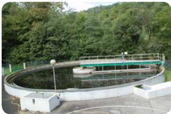
Bassin de décantation
