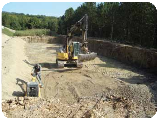
Terrassement des bassins
