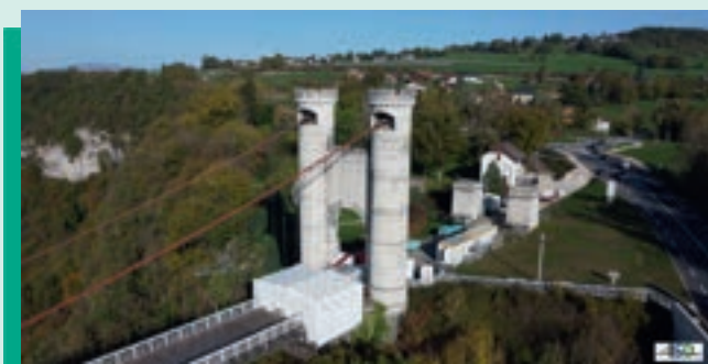
Bâche étanche thermo-rétractable fixée à l'échafaudage multidirectionnel - Essais de convenances en octobre 2022
