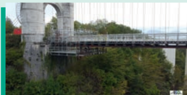
Echafaudage multidirectionnel - Essais de convenances en octobre 2022
