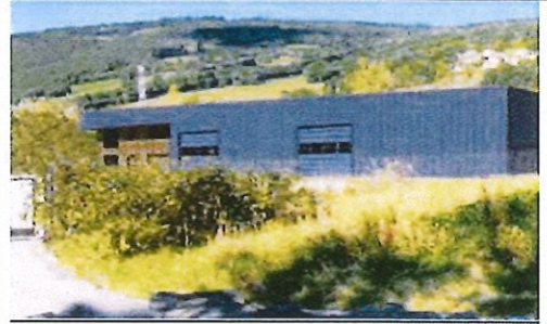
Bâtiment du nouveau CTM
