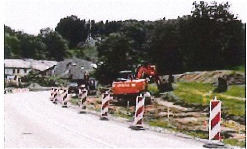
Travaux sur la RD15
