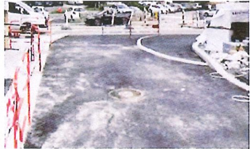
Travaux rue de la Charrière
