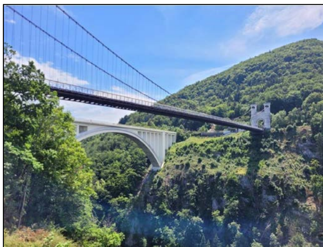
Éléments du patrimoine, Pont de la Caille (source : Cereg, Juillet, 2022)
